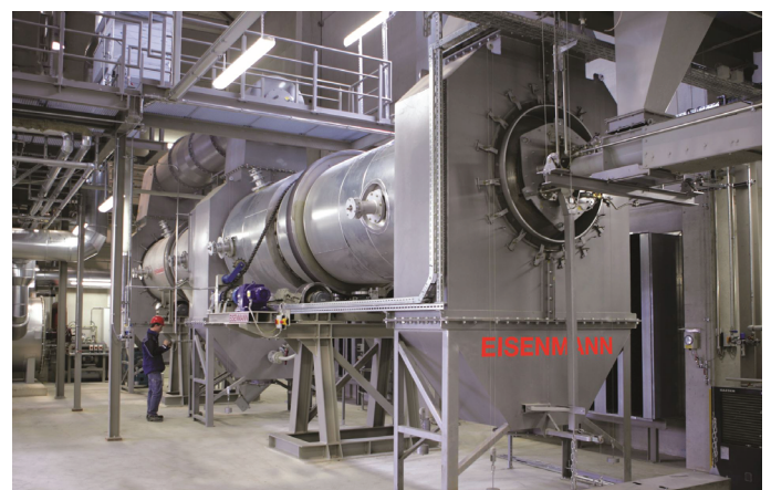
Drehrohranlage zur Behandlung von teerhaltigem Straßenaufbruch.
